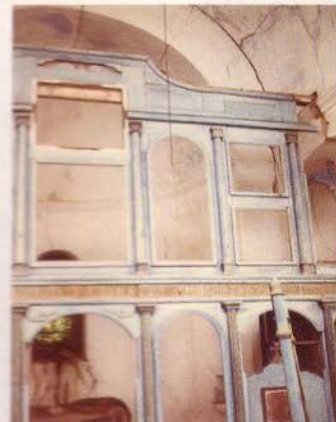
Детаљ ентеријера са оштећеном иконостасном преградом
